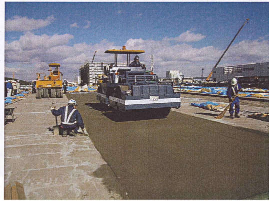
振動ローラによる締固め
