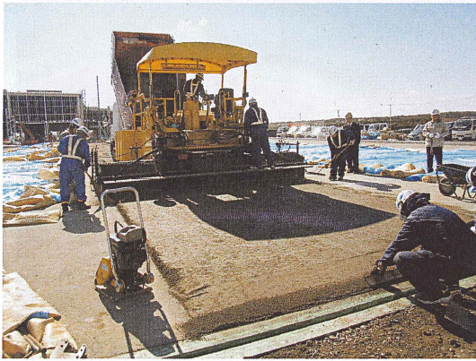
アスファルトフィニッシャーによる敷きならし
